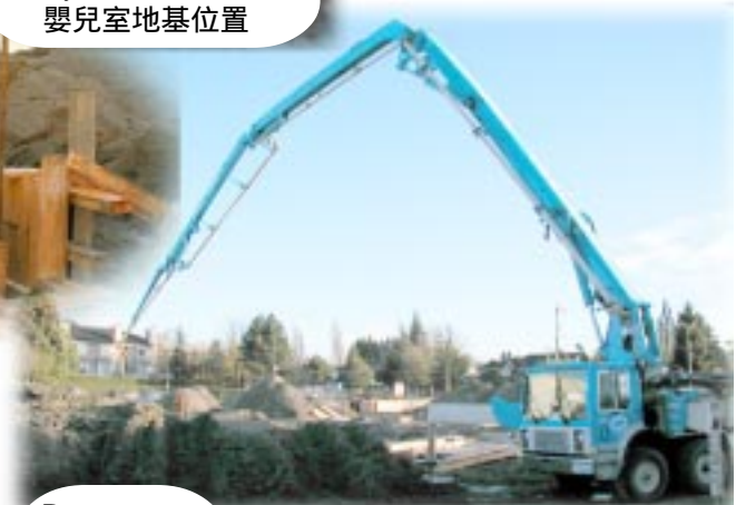
Pour concrete 灌混凝土
