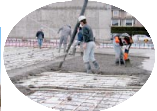
Workers work hard to level the floor 工人努力造好地台工作
