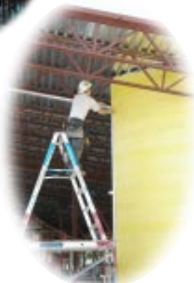
Window framing 鐵框工程
